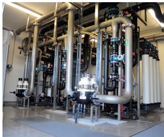
Vodarna Virje z ultra filtracijskimi enotami
