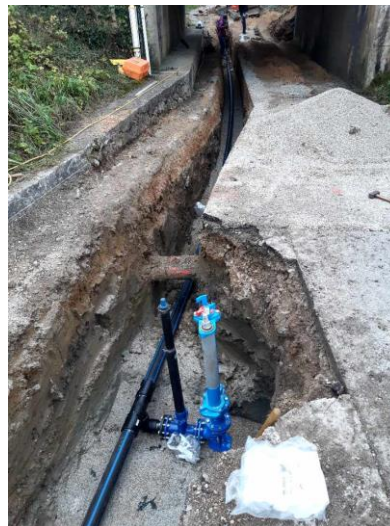
Vgradnja blatnika pred železniškim podvozom v Goričici
