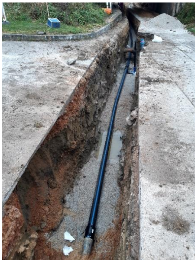
Vgradnja sekundarnega cevovoda Goričica
