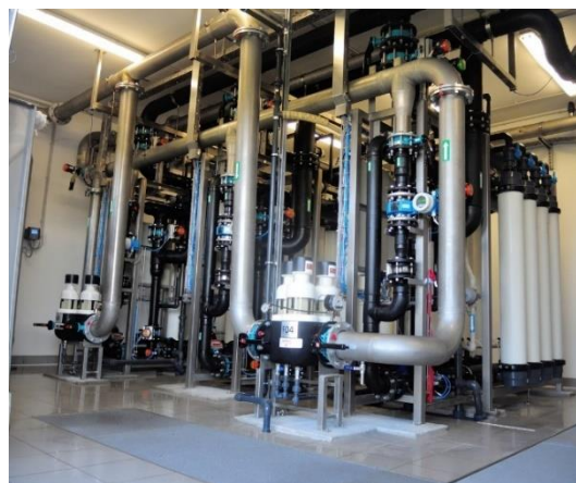
Vodarna Virje z ultra filtracijskimi enotami
