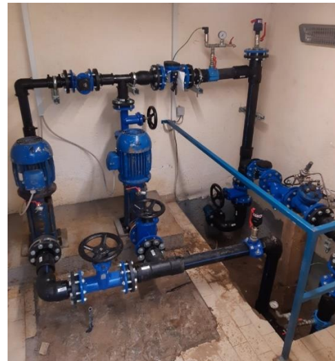
Prečrpališče po predelavi strojnih inštalacij
