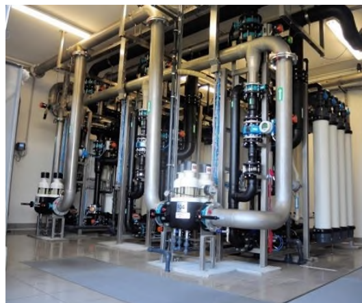
Vodarna Virje z ultra filtracijskimi enotami
