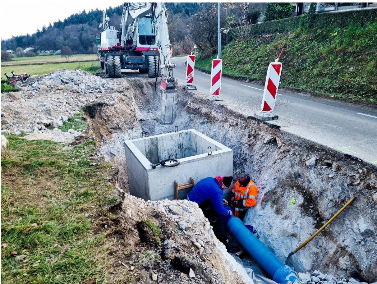
Slika: Obnova primarnega vodovoda NL DN250 Vodarna Virje - Podpeč
