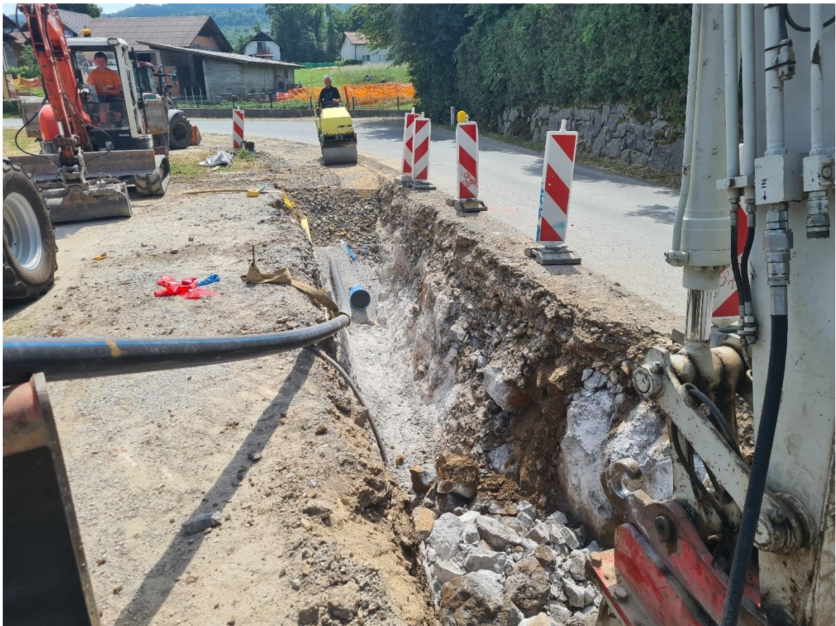
Obnova primarnega in sekundarnega vodovoda NL DN250 Vodarna Virje - Podpeč
