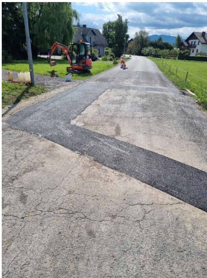
Asfaltiranje prekopa izvedbe vodovodnega priključka
