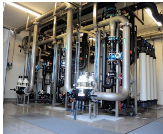
Vodarna Virje z ultra filtracijskimi enotami
